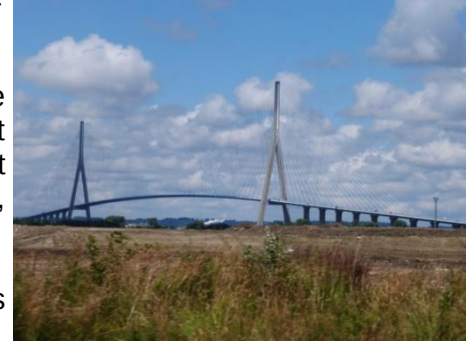
Pont de Normandie
